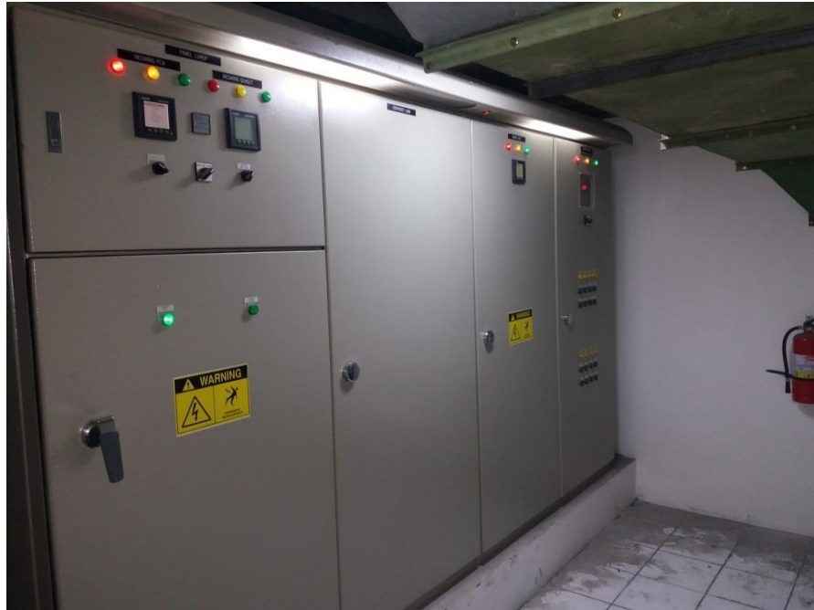
Gambar 2.8 Panel LVMDP pada Saka Primiere Hotel
