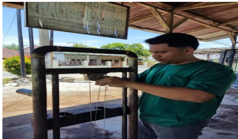
Gambar 4.10 pemasangan sling pada troli
