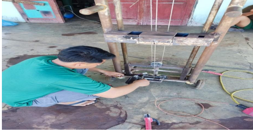
Gambar 4.12 proses pemasangan motor listrik ke dudukan
