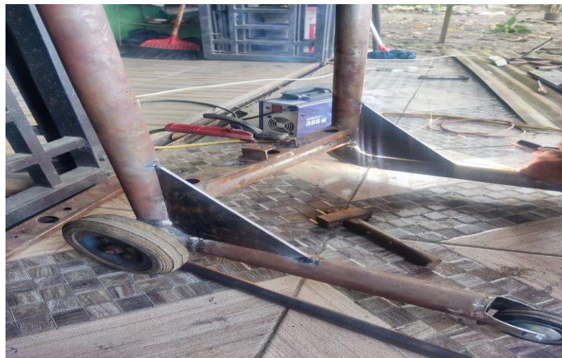
Gambar 4.7 pemasangan plat penahan pada kerangka
