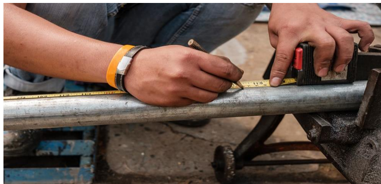
Gambar 4.1 proses pengukuran besi
