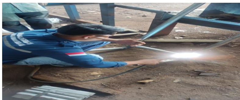
Gambar 4.2 penyambungan besi kerangka
