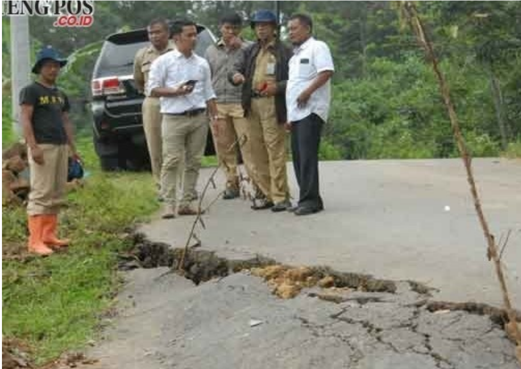
Gambar 2.6: Amblas ( Depression ). Sumber : https://dpu.kulonprogokab.go.id/detil/64/
