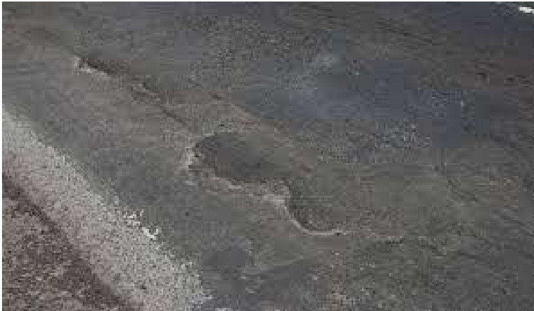
Gambar 2.2: Kegelumutan.
