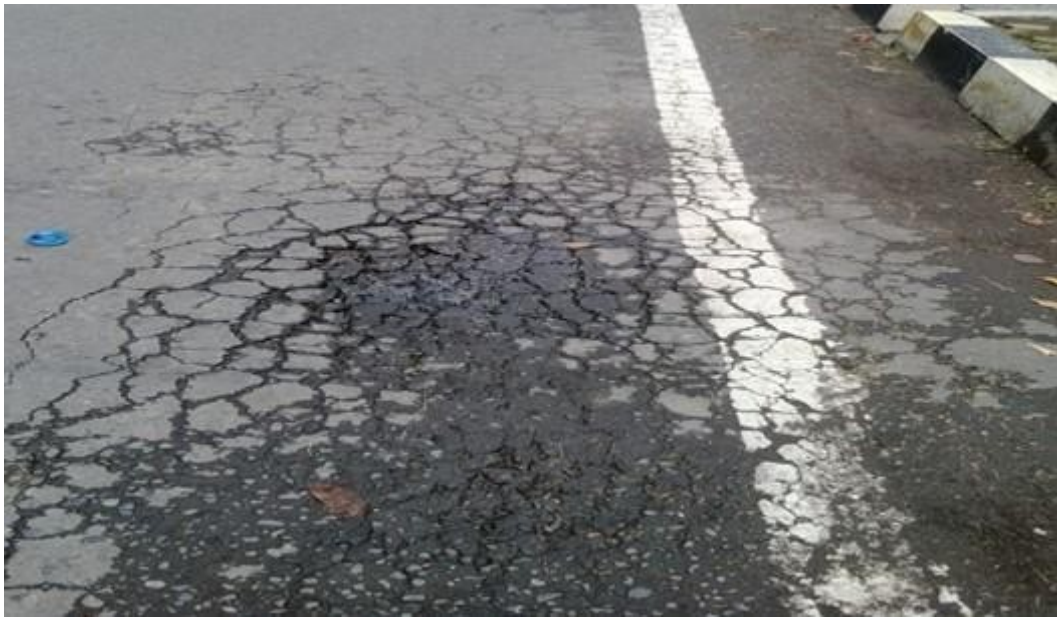
Gambar 2.1: Retak Kulit Buaya.
