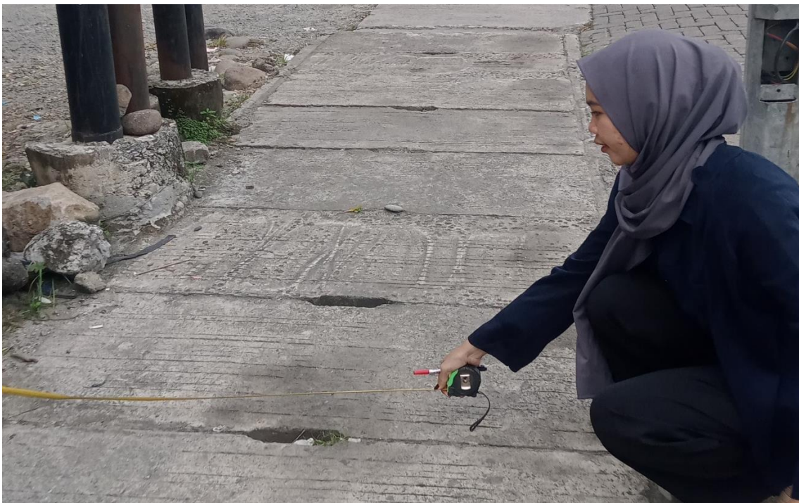
DOKUMENTASI 2 Pengukuran Bahu Jalan
