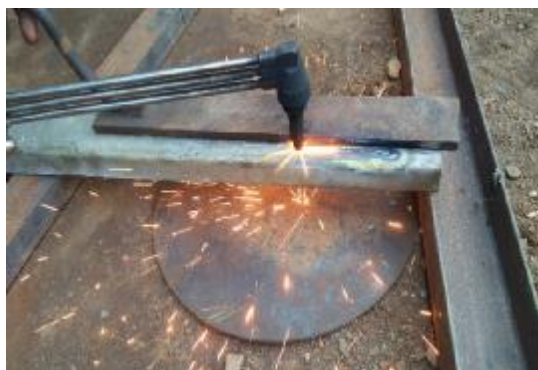
Gambar 4.11. Proses pembuatan lubang pengunci motor
