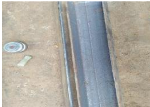
Gambar 4.7. Baja UNP sebagai baut penggunci pillau block
