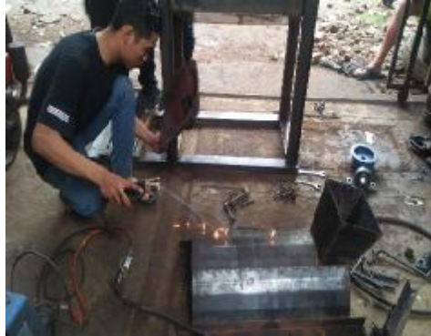
Gambar 4.49. Pengelasan penutup mata pisau
