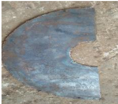
Gambar 4.47. Plat yang sudah di potong
