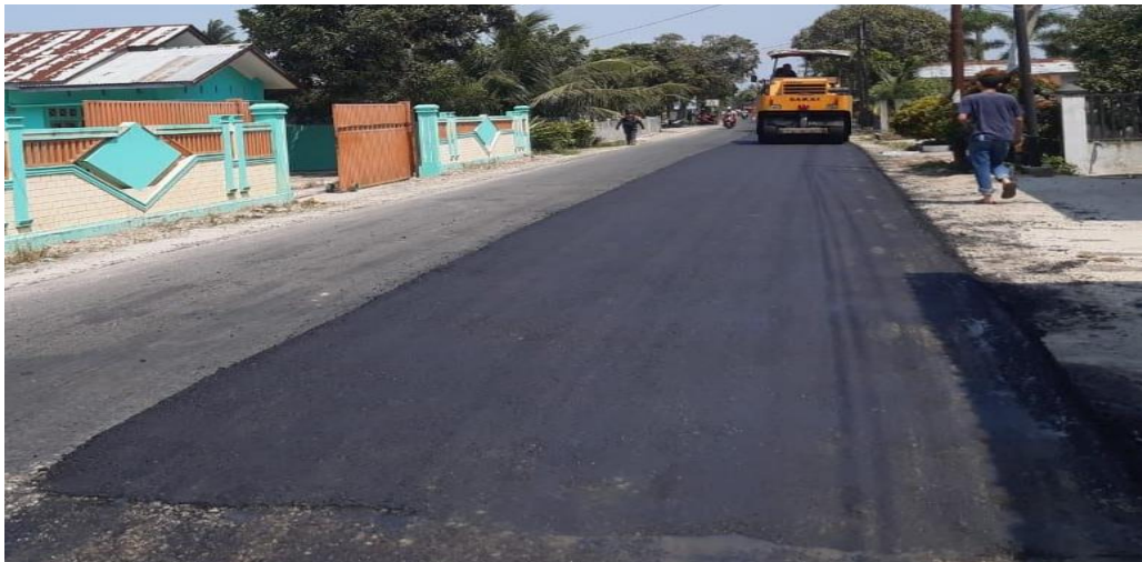
Gambar L.2 Dokumentasi Pengerjaan Lapis Permukaan
