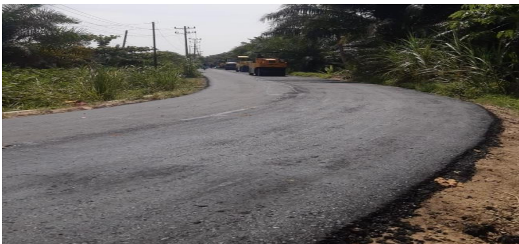
Gambar L.3 Dokumentasi Pengerjaan Lapis Permukaan
