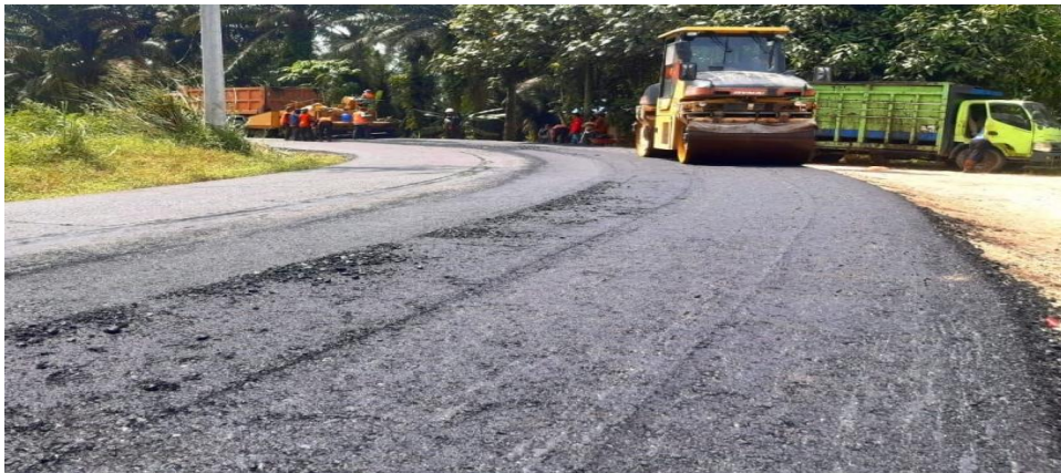
Gambar L.1 Dokumentasi Pengerjaan Lapis Permukaan
