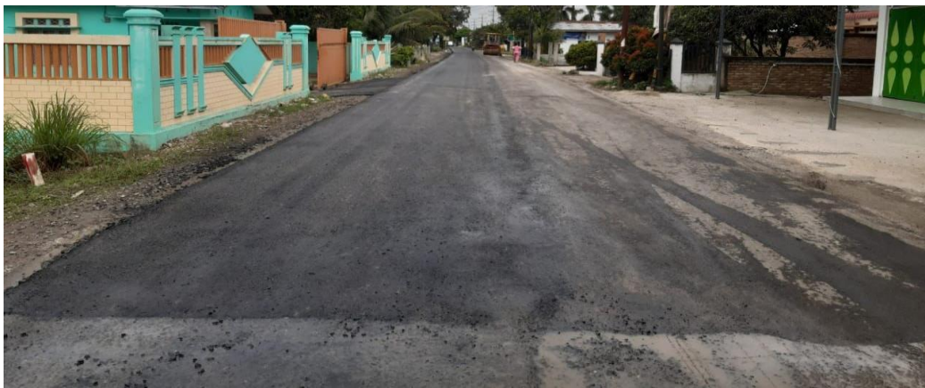
Gambar L.5 Dokumentasi Pengerjaan Lapis Permukaan
