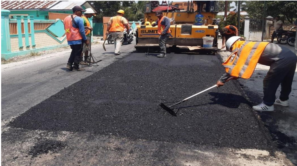
Gambar L.4 Dokumentasi Pengerjaan Lapis Permukaan
