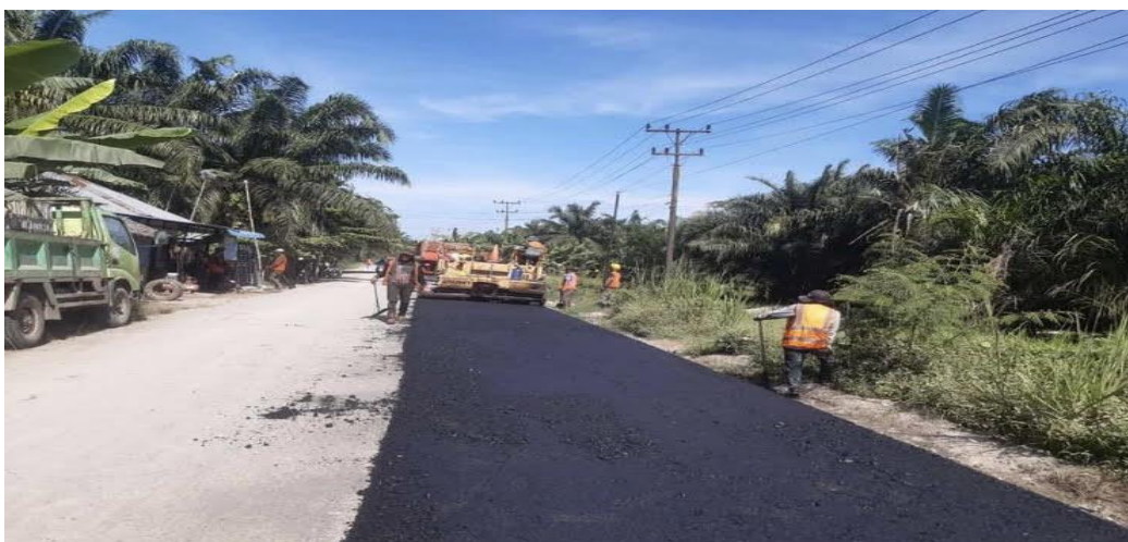
Gambar L.6 Dokumentasi Pengerjaan Lapis Permukaan
