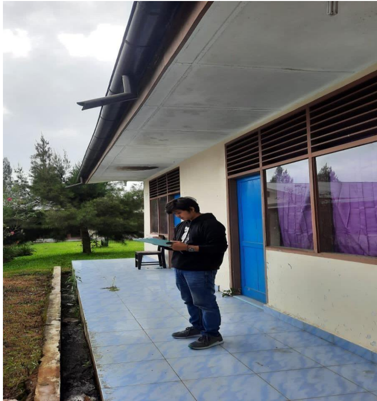
Gambar L.1 : Kondisi Asrama Poltekes Kabanjahe
