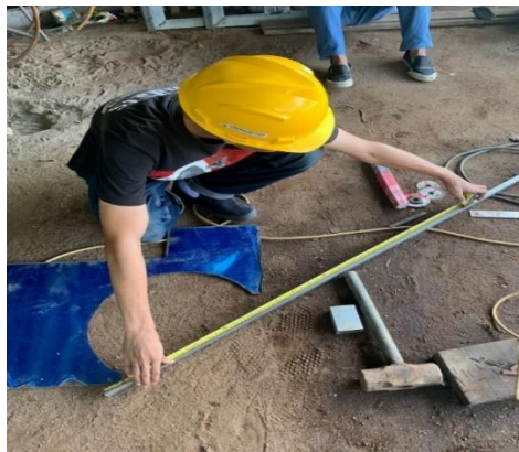
Gambar 4. 20 Pengukuran besi hollow
