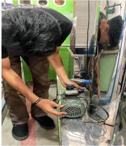
Gambar 4. 28 Pemasangan pompa air
