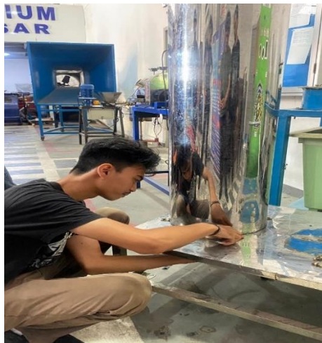
Gambar 4. 23 Penguncian baut dan mur
