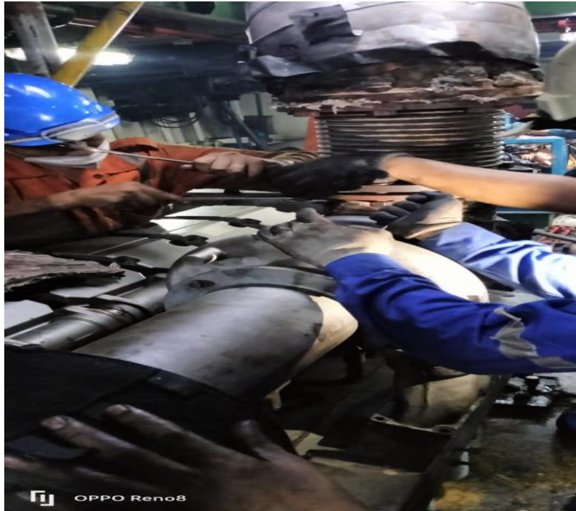
Gambar 4.3 Pembongkaran Cylinder Head
