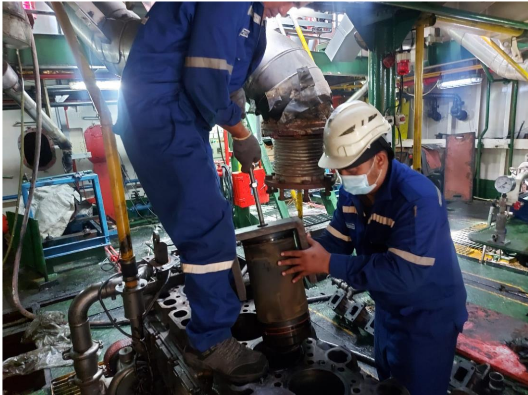
Gambar 4.5 proses pengangkatan piston
