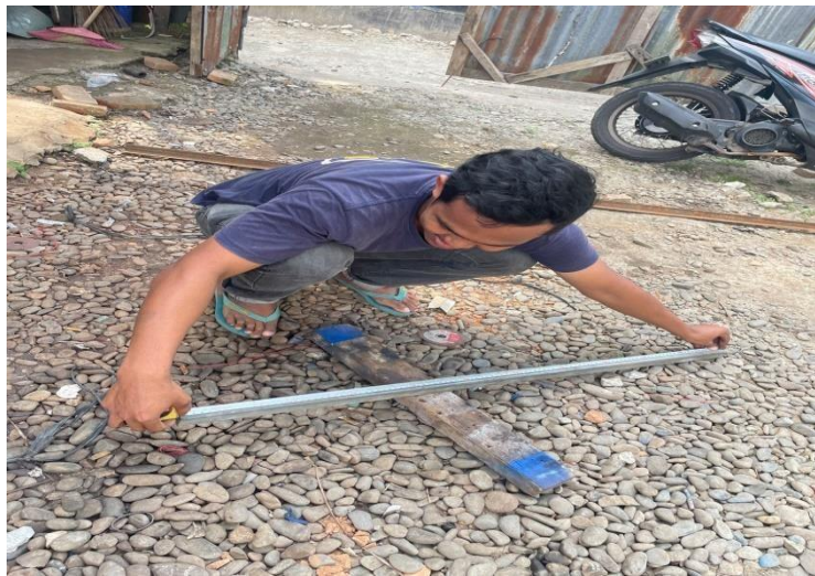
Gambar 4.5. Proses Pengukuran besi hollow
