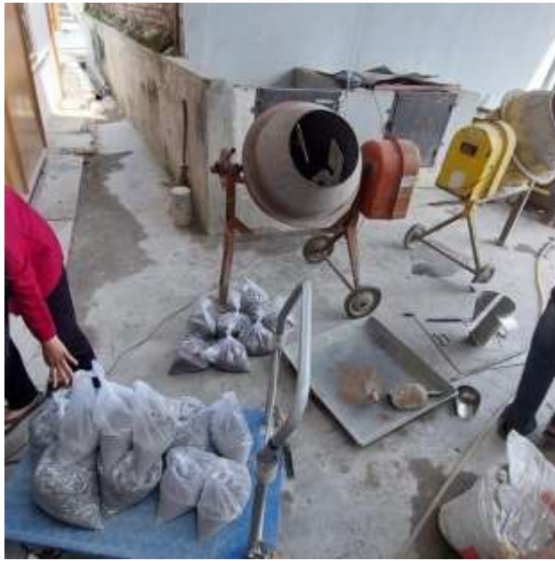
Gambar L.9: Persiapan pembuatan benda uji.
