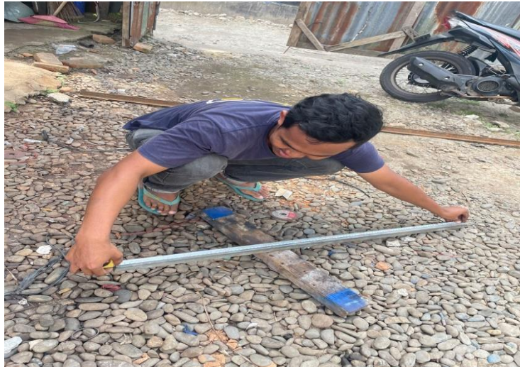
Gambar 4.4. Proses Pengukuran besi hollow
