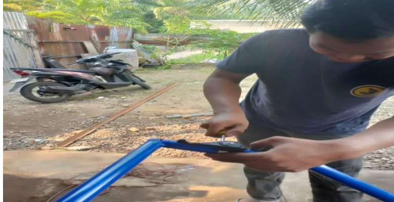
Gambar 4.16. Proses pemasangan pegas
