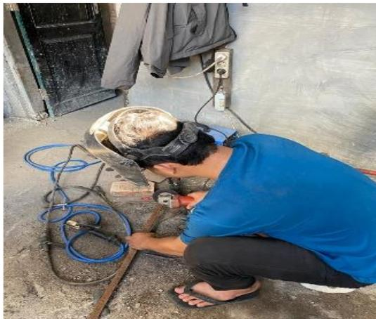
Gambar 4.4 Pemotongan Plat
