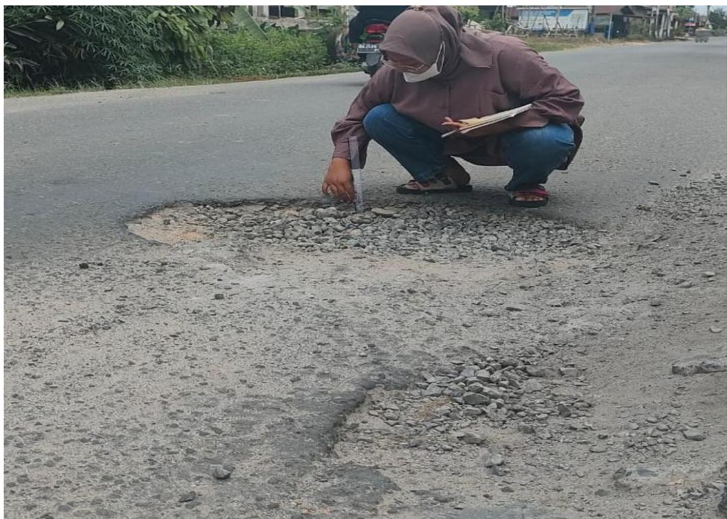
Gambar L.4 : Mengukur Data Kerusakan Jalan
