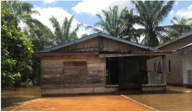
Gambar 8. Bangunan Semi Beton
