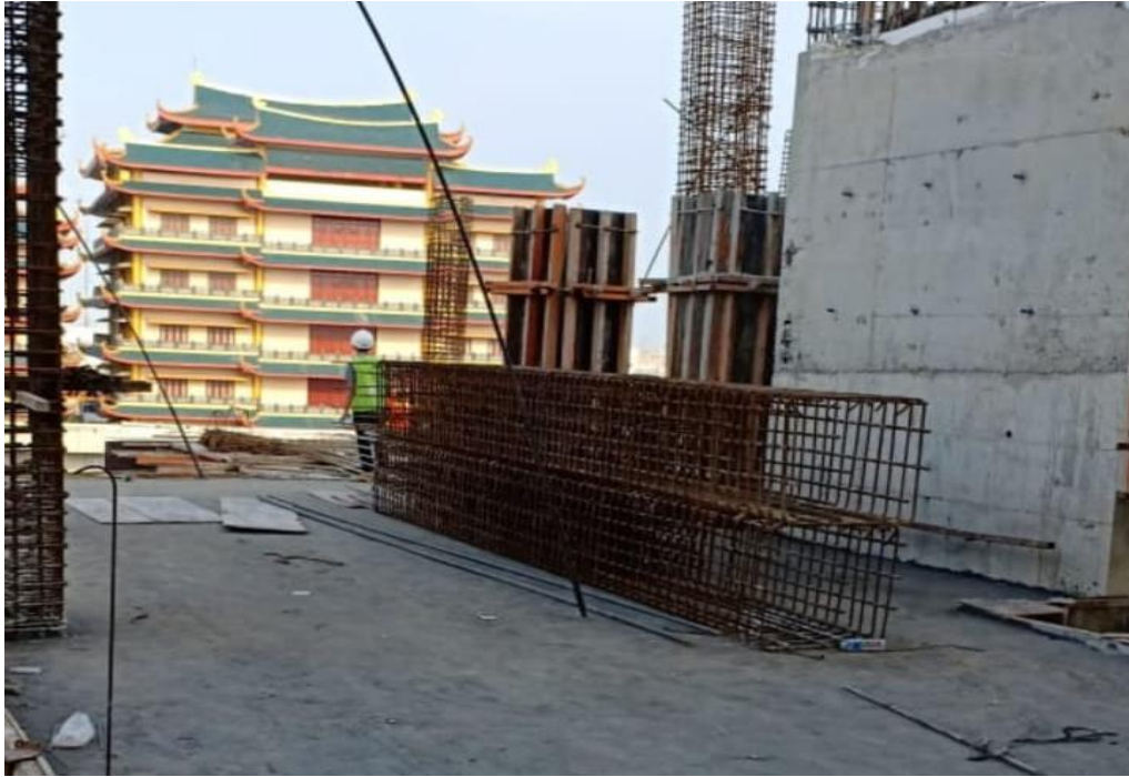
Pemasangan Bekisting Phenolic Pada Kolom
