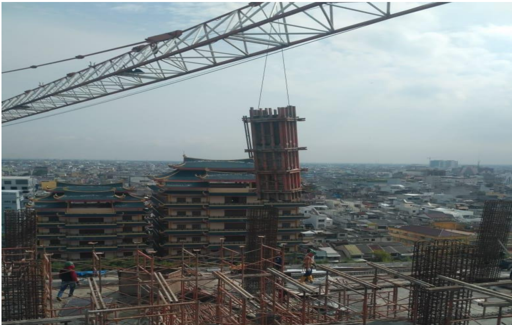
Langsir bekisting phenolic ke lantai atas menggunakan tower crane
