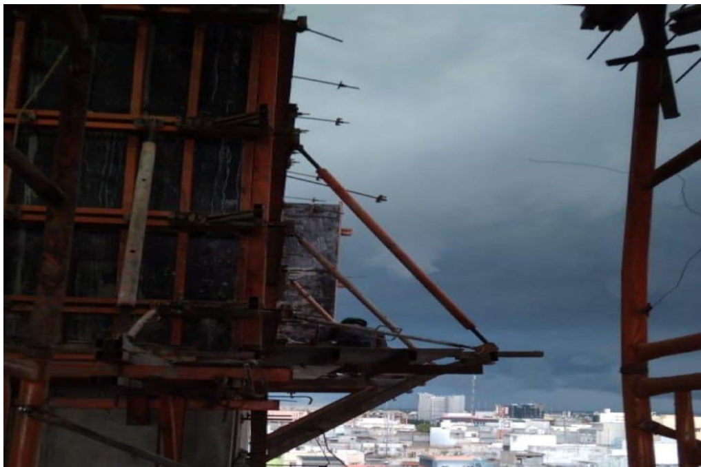
Bekisting Phenolic Yang Siap Untuk Di Cor
