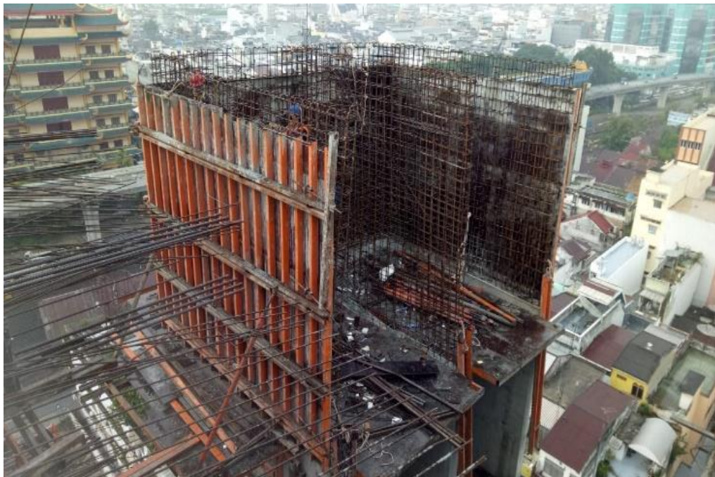
Pemasangan Bekisting Phenolic Pada Dinding Core Wall
