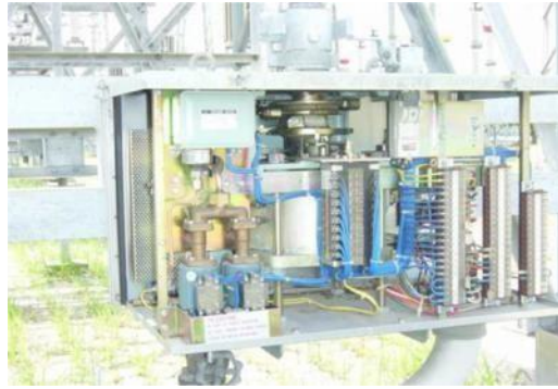
Gambar 2.27 Mekanik PMS Tekanan Udara
