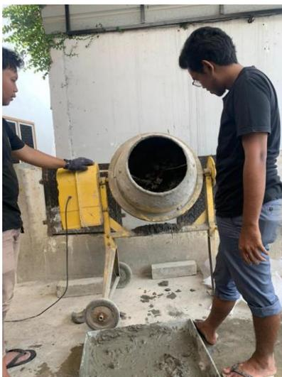
Gambar L-3: Pembuatan Campuran Beton dengan Mixer
