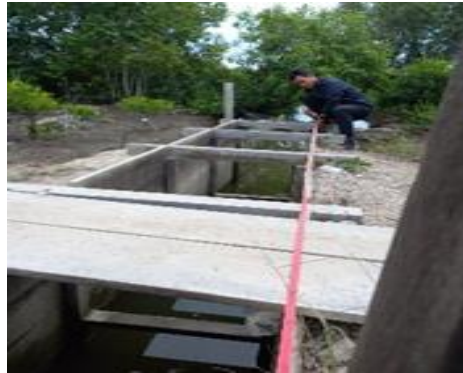
Gambar 3. 16 Penampang yang telah di aliri air
