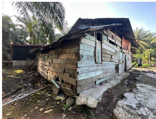
Lampiran 2: Kondisi Tampak belakang Rumah
