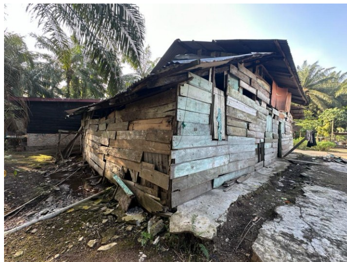
Gambar 3.4: Kondisi Tampak belakang Rumah
