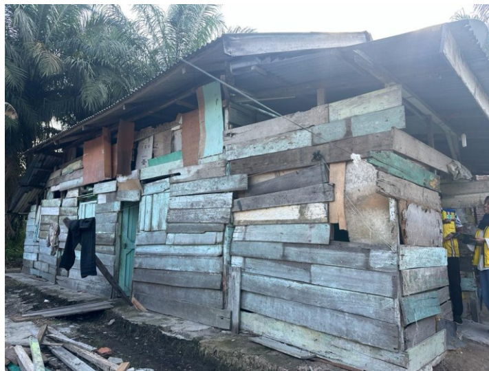
Gambar 3.3: Kondisi Tampak Samping Rumah
