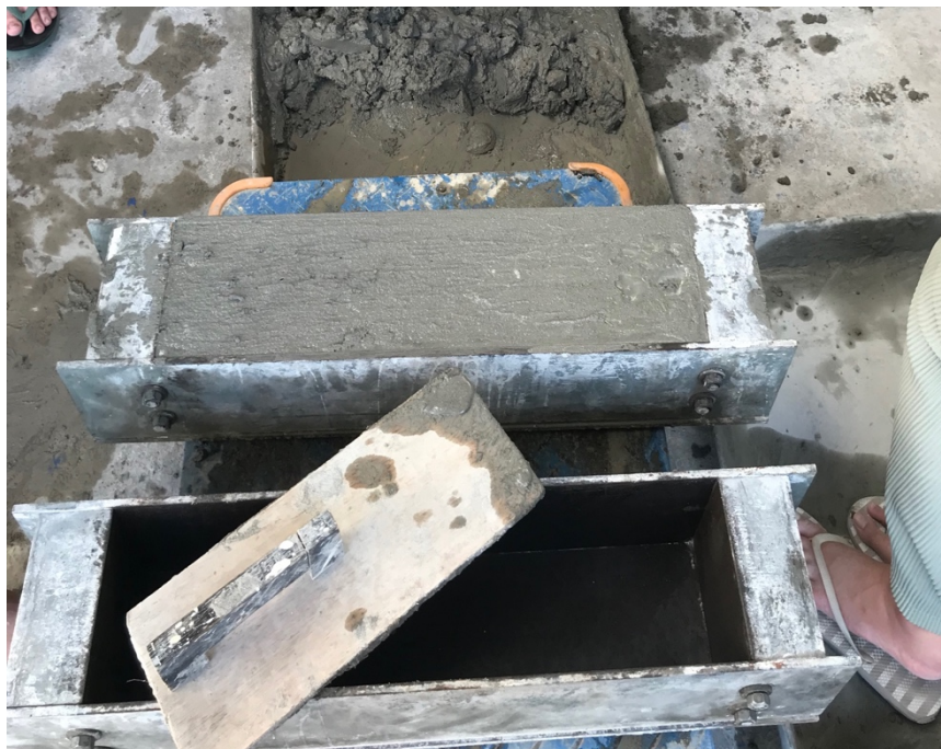
Gambar L.8: Beton segar dimasukkan ke dalam bekisting
