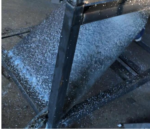
Gambar 4. 9. Hasil Pemasangan Plat Cover Pelindung Mesin
