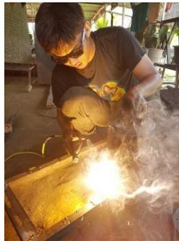
Gambar 4.18 Pengelasan sisi bawah wadah briket
