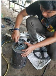
Gambar 4.21 Memasang bearing pada sisi atas wadah briket.
