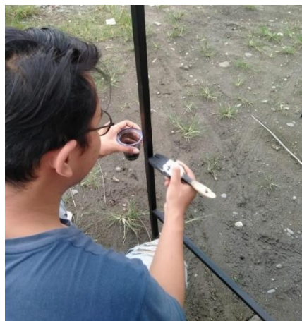
Gambar 4.10 Proses Pengecatan
