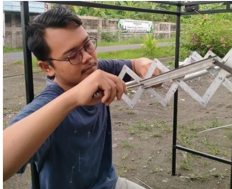
Gambar 4.8 Pemasangan Jemuran Lipat
