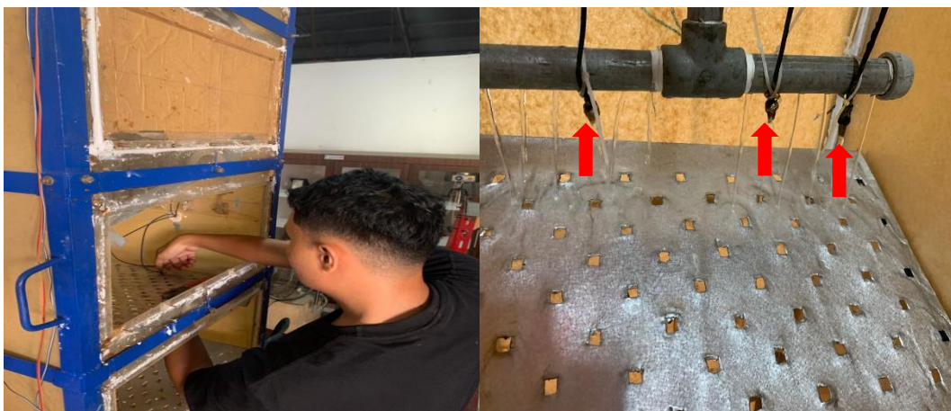
Gambar 4. 18 Pemasangan Sensor Ke Wet Cooling Tower
