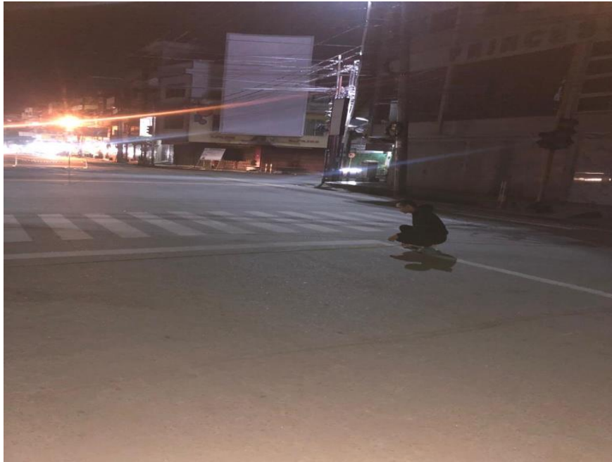
Gambar L3: Mengukur lebar jalan
