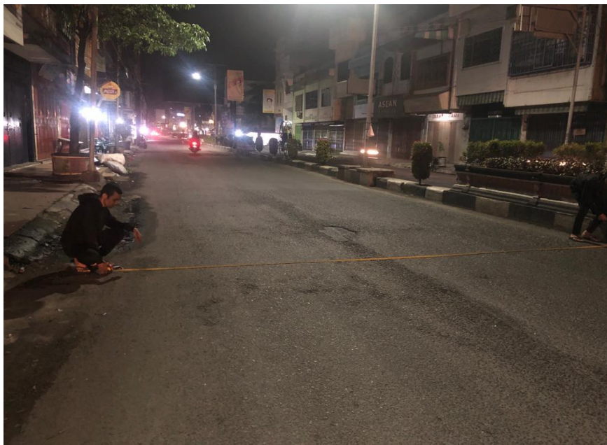
Gambar L2: Mengukur lebar jalan
