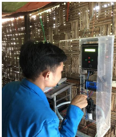
Gambar 3. Proses Pemasangan Sistem
