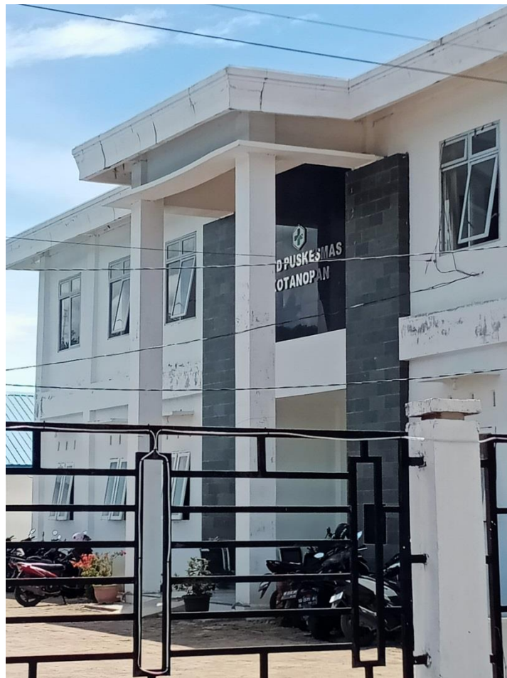
Gambar 8. Gedung Utama Puskesmas Kotanopan
