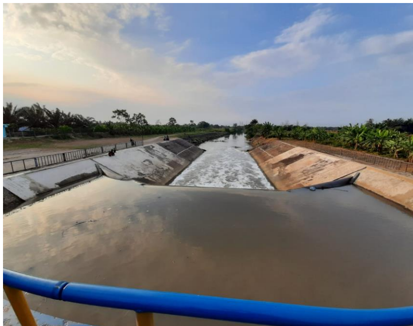
Gambar.2. Bendung karet tampak atas
