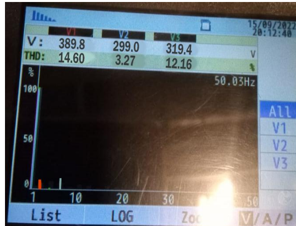
Gambar 4. 2 : Data Pengukuran Gardu Distribusi hingga Pada Panel Trafo
