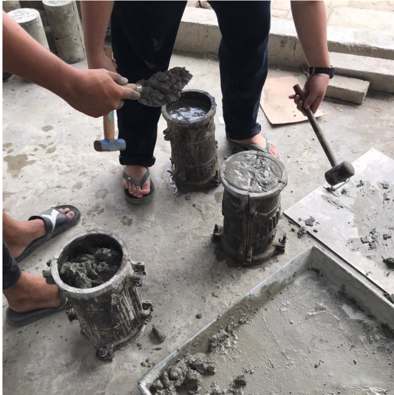
Gambar L. 15 : Beton Segar Dimasukkan ke dalam Bekisting
