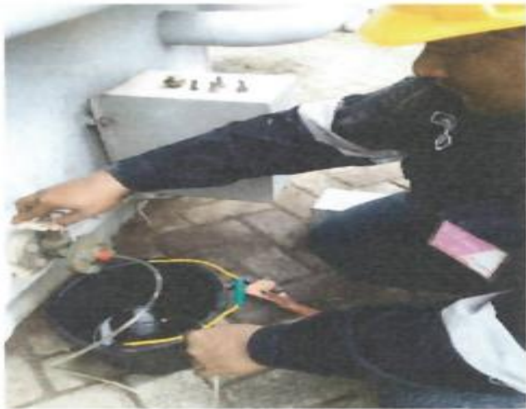
Gambar 3.2. Proses pengambilan minyak isolasi trafo
