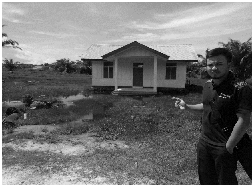
Kantor Desa Rawa Makmur masih tahap pembangunan
