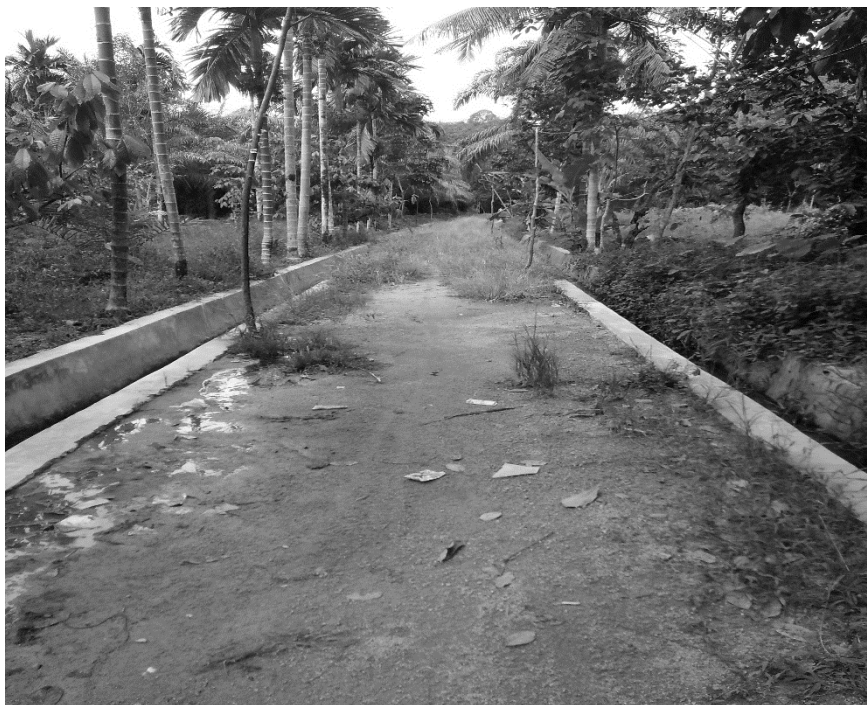
Pembangunan Drainase Tahun 2016
