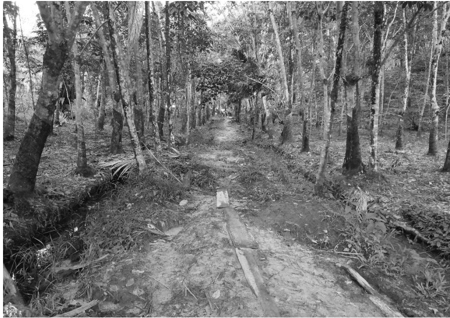
Pembangunan Drainase Tahun 2015
