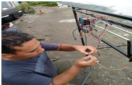
Gambar 3.32 Penyambungan Kabel Daya Motor Servo ke Buck Converter
