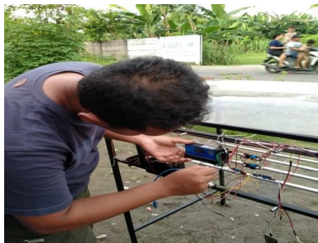
Gambar 3.26 Pemasangan Solar Charge Controller ke Papan Akrilik
