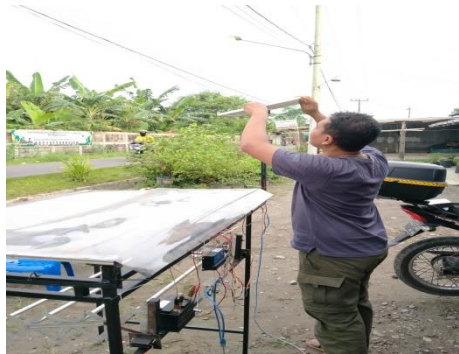
Gambar 3.25 Pemasangan Panel Surya ke Dudukan Yang Telah Dibuat
