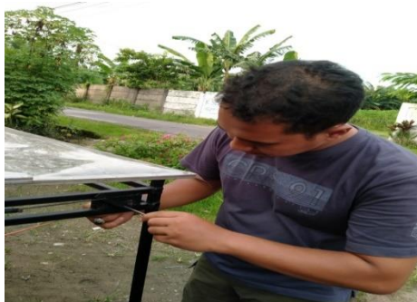
Gambar 3.30 Pemasangan Motor Servo ke Breket Dudukan Untuk Atap Jemuran
