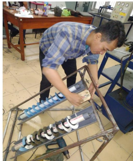
Gambar 4.16 Pemasangan Dudukan Generator
