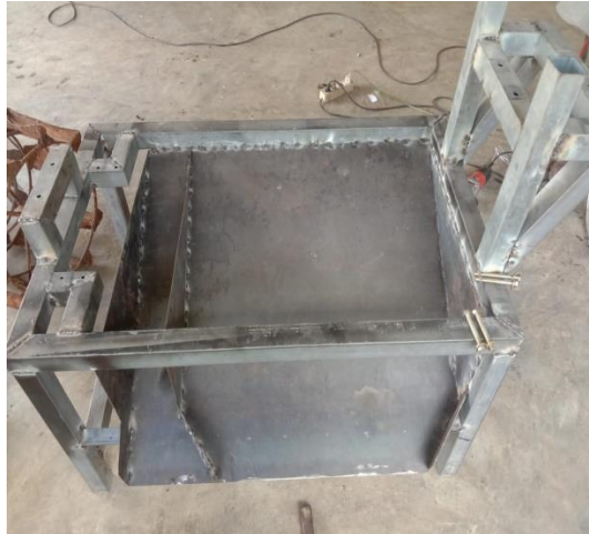
Gambar 4.6 Pembuatan hopper 1 dan hopper 2
