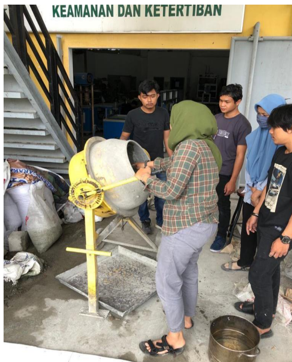
Gambar L- 18 : Mengaduk Semua Agregat
