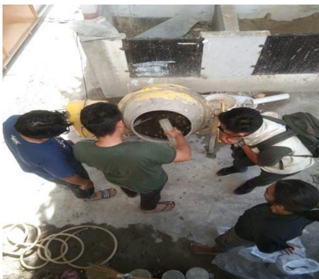
Lampiran 28 : Proses Pembuatan Adukan Beton.
