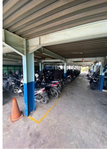
Gambar 2. Kondisi lahan parkir lantai 1
