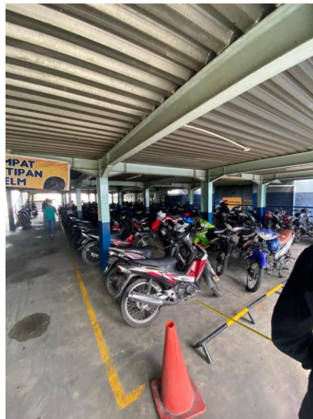
Gambar 3. Kondisi lahan parkir lantai 2
