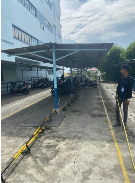
Gambar 1. Kondisi lahan parkir lantai 3
