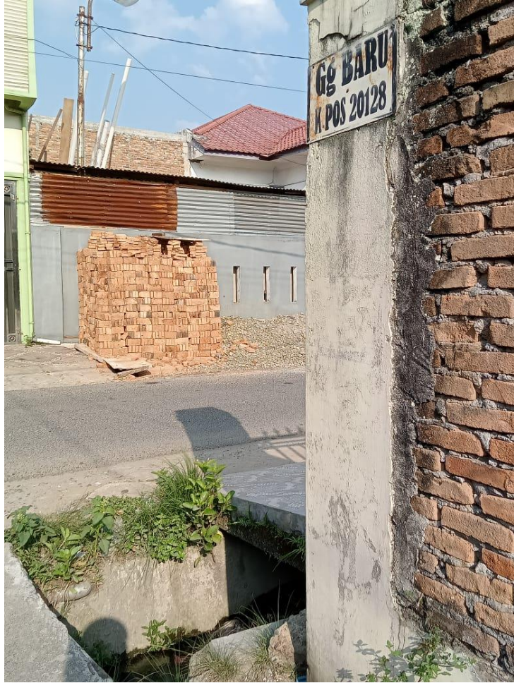
Lampiran 1. 5 Kondisi parit di Gang Baru
