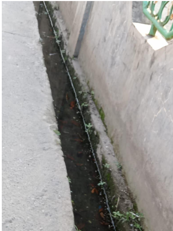
Lampiran 1. 8 Kondisi parit di Gang Harmoni
