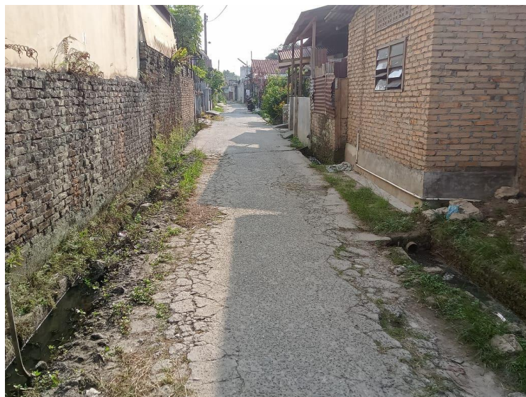
Lampiran 1. 4 Kondisi parit di Gang Baru
