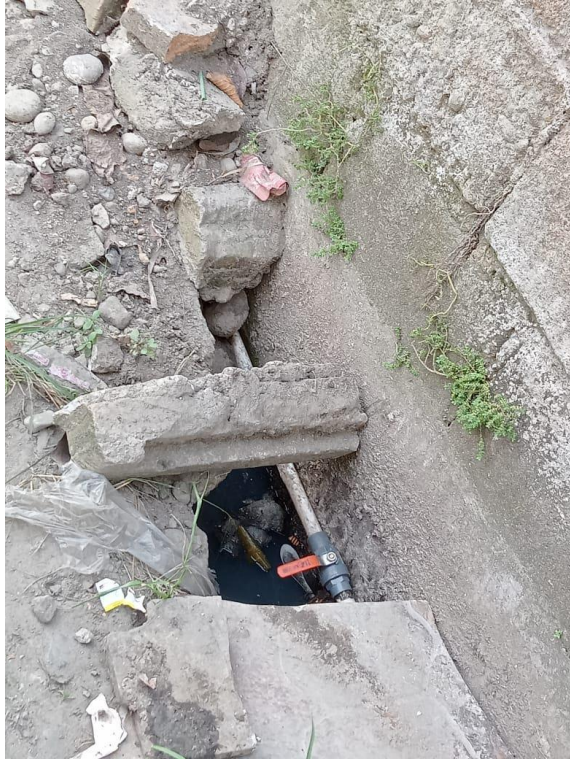
Lampiran 1. 9 Kondisi parit di Gang Harmoni
