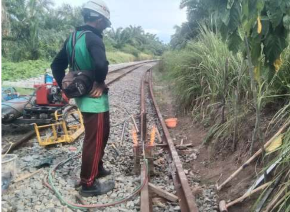
Lampiran 3. Las thermit rel R.54 yang akan dilakukan penggantian.
