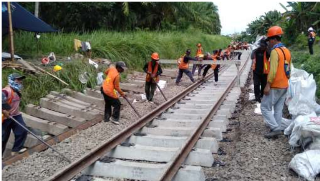
Lampiran 4. Penggantian rel baru R.54 pada struktur jalan rel.
