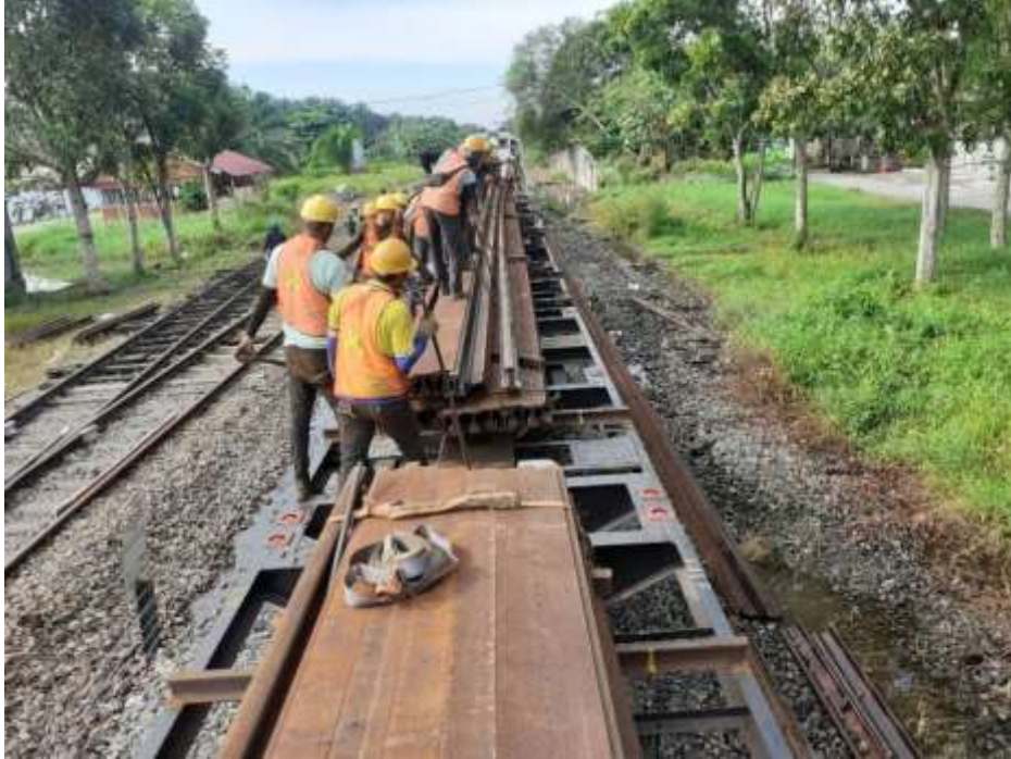
Lampiran 1. Pengeceran atau mobilisasi rel R.54 menggunakan KLB.
