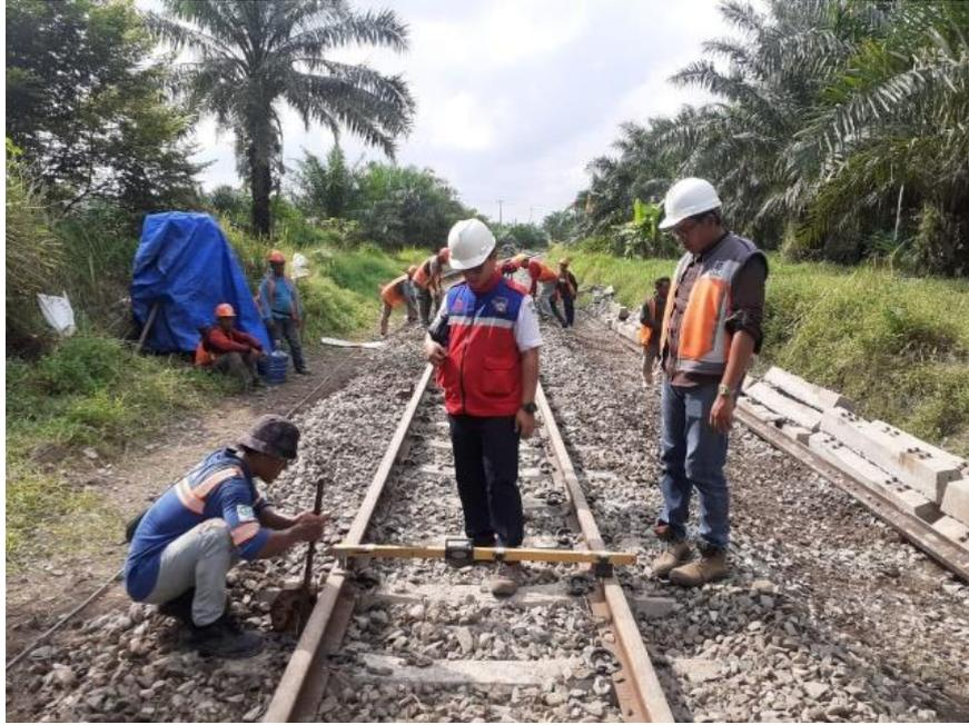
Lampiran 3. Pengukuran elevasi struktur jalan rel menggunakan alat ukur matisa.
