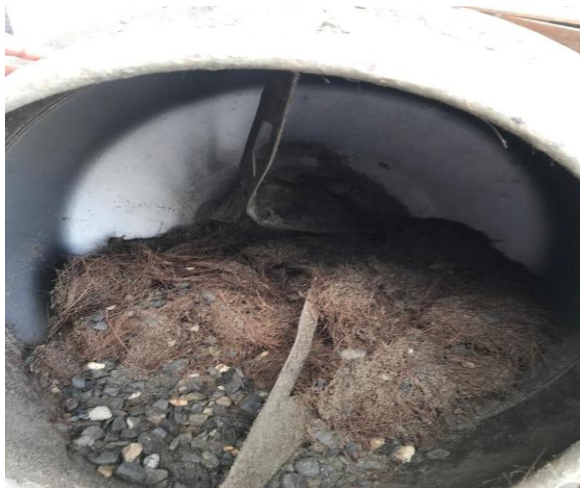
Gambar L-23: Proses pembuatan adukan beton.
