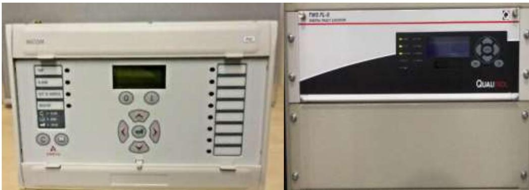
Gambar 3.1 Rele Jarak dan *Travelling Wave Signal*
