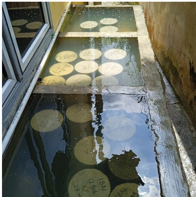
Gambar L12: Dokumentasi proses perawatan beton (perendaman)
