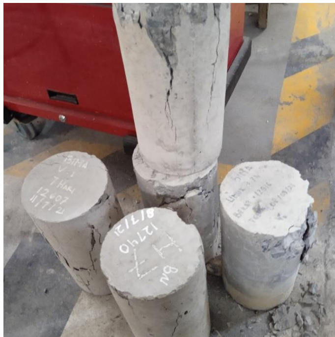
Gambar L14: Dokumentasi beton yang sudah diuji
