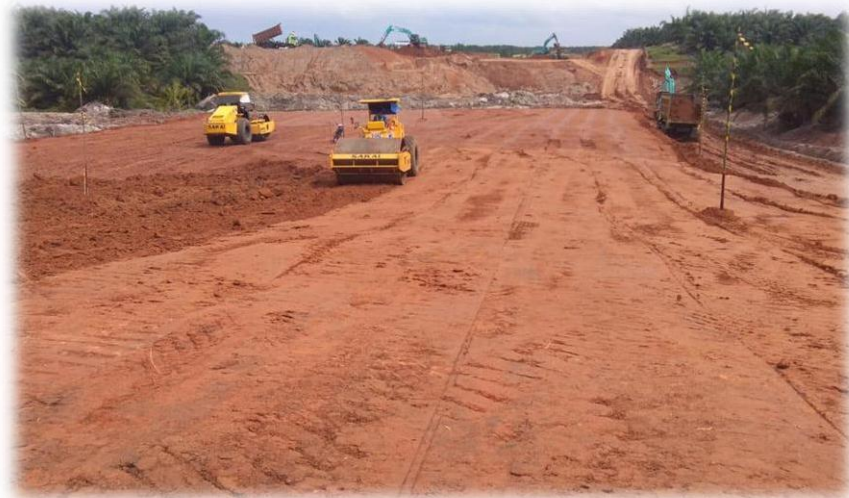
L.4: Proses Pemasatan Timbunan
