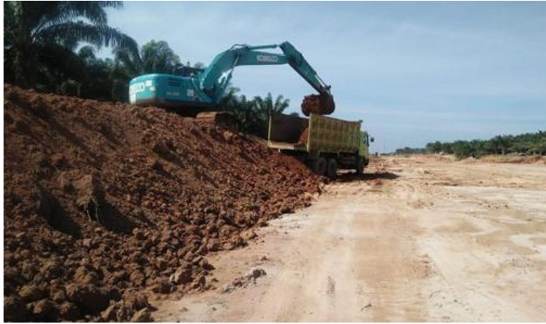
L.5 : Excavator Sedang Memuat Tanah
