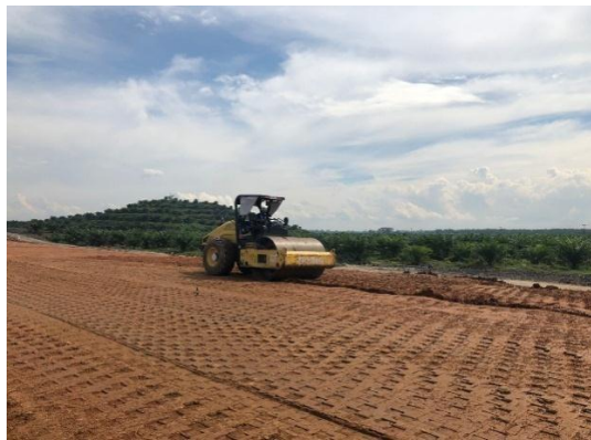
Gambar 2.4: vibro roller sedang memadatkan tanah
