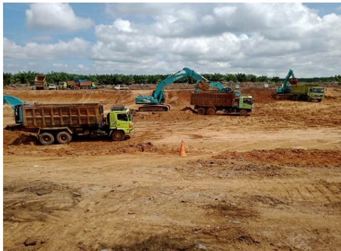
Gambar 2.2: Dump truck sedang melakukan pengisian material
