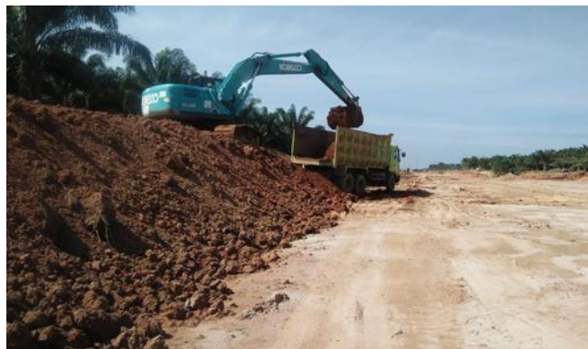
Gambar 2.1: Excavator sedang memuat material.
