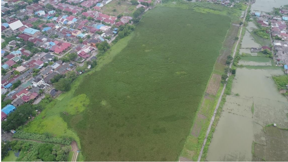
Gambar L.1 : Kondisi Kolam Retensi Menggunakan Drone.
