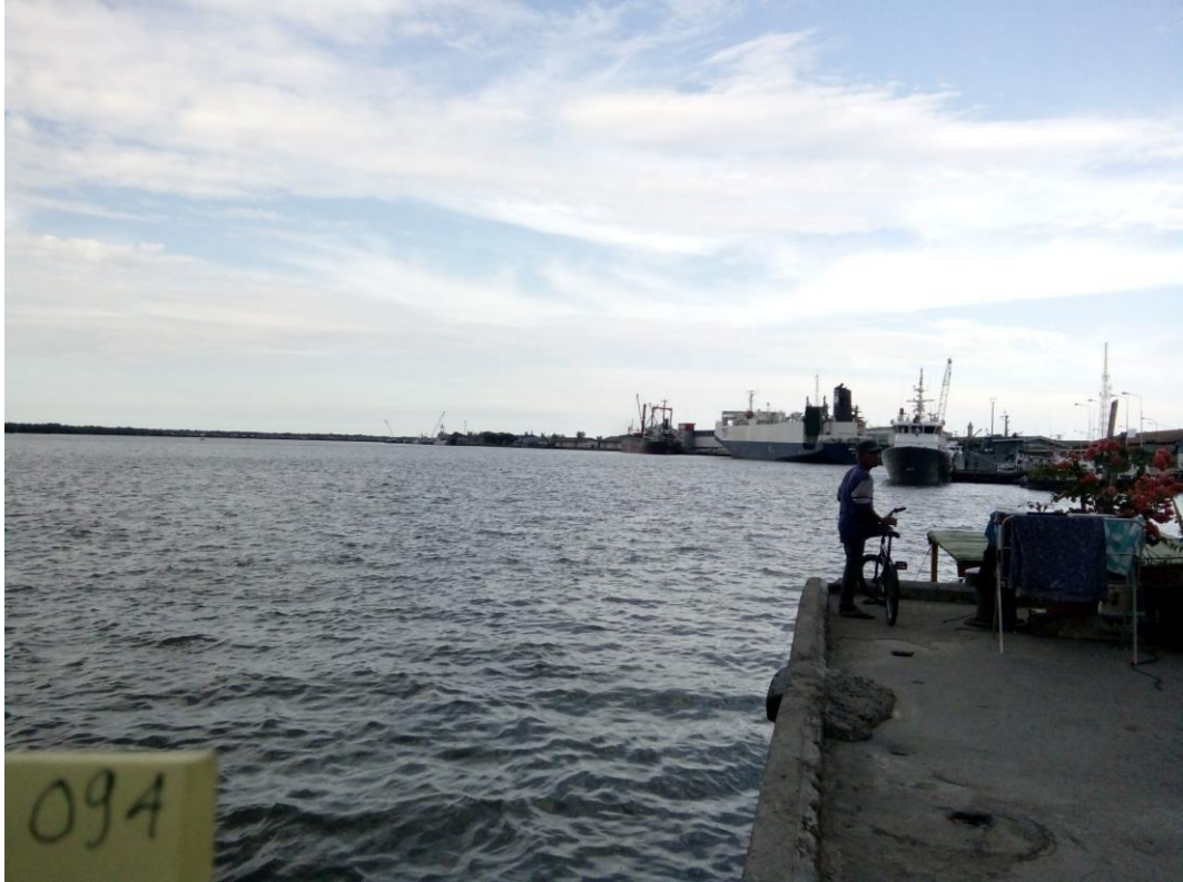
Lampiran 1. 5 Kondisi Marking 094
