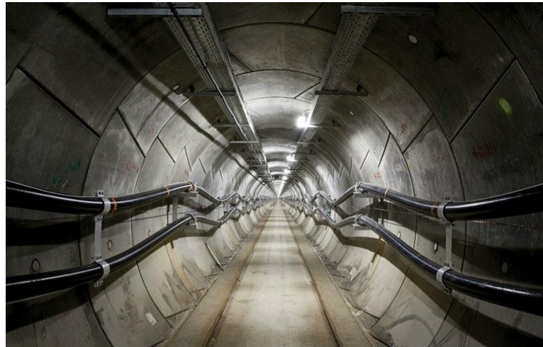
Gambar 2.3 Saluran Kabel Bawah Tanah
