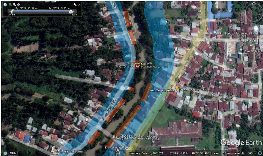
Gambar 4.14: Lokasi bangunan melewati batas garis sempadan
