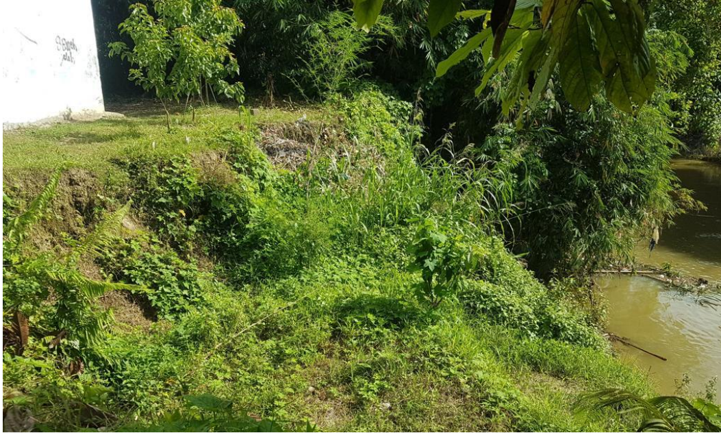
Gambar L.0.1: Lokasi longsor dititik 158 Desa Desa Tanjung Gusta, Kecamatan Sunggal, Kabupaten Deli Serdang
